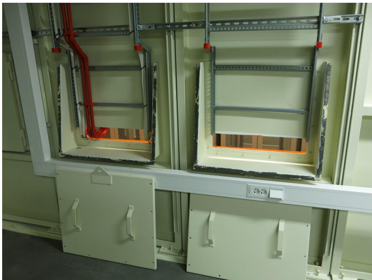
Rys. 5. Przykład szykany horyzontalnej dla mediów i okablowania dostarczanych do wnętrza klatki ołowianej.
